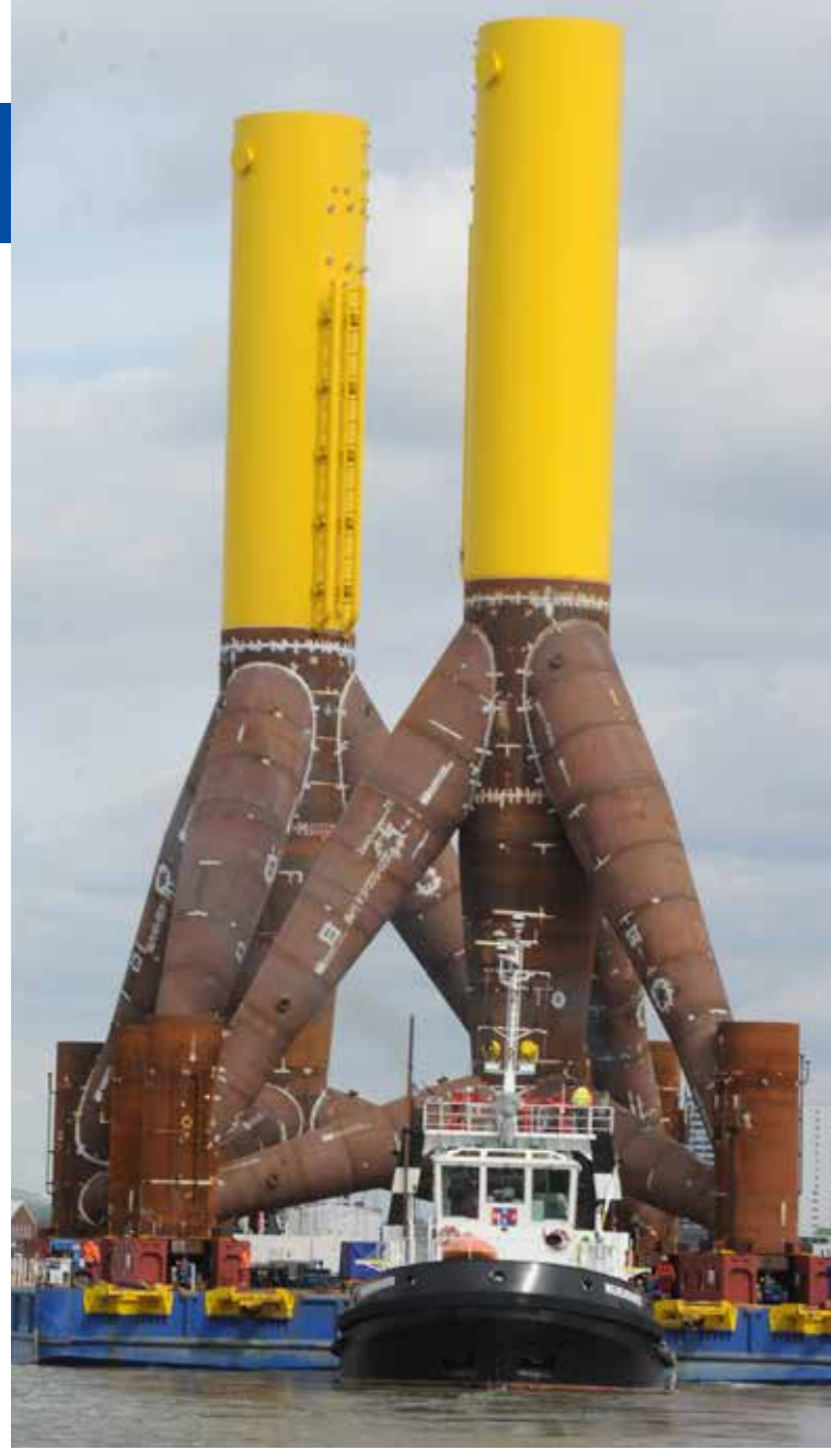
Tripod-Transport in Bremerhaven mit dem Ponton OFFSHORE BHV 1
